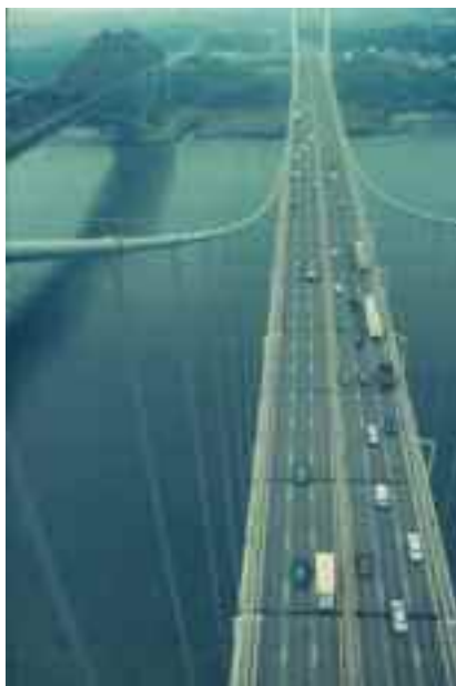
Du haut de l'un des piliers du Pont Pierre-Laporte lors d'une inspection
